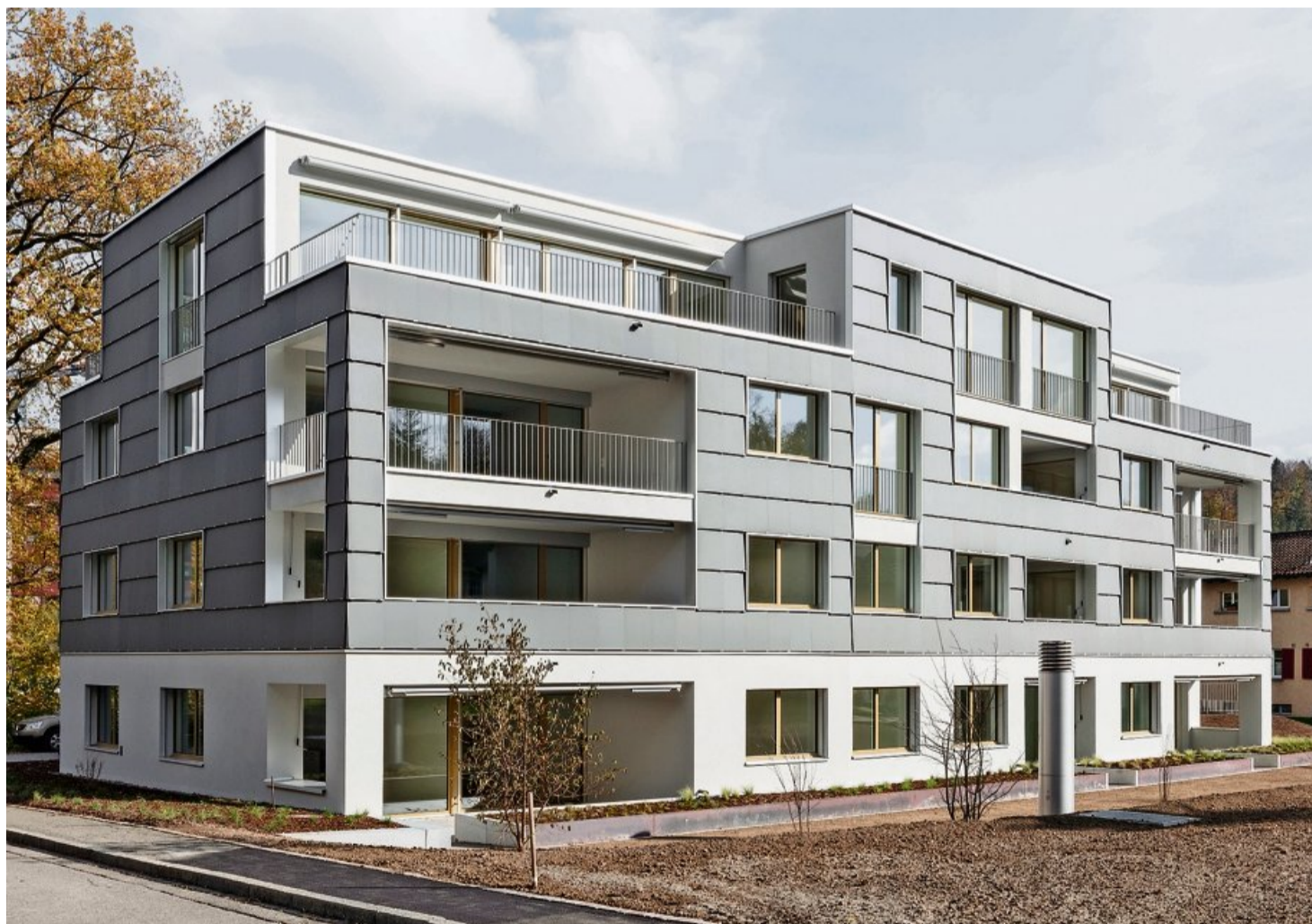
Über 1000 Solarplatten in derselben Grösse bedecken die Fassade des Zukunftshauses in Zürich-Leimbach.
