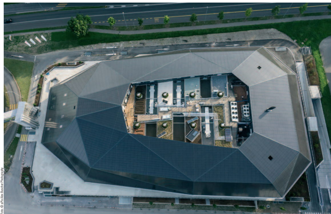
Foto aerea dell'Umwelt Arena, con le unità esterne degli impianti in copertura.
